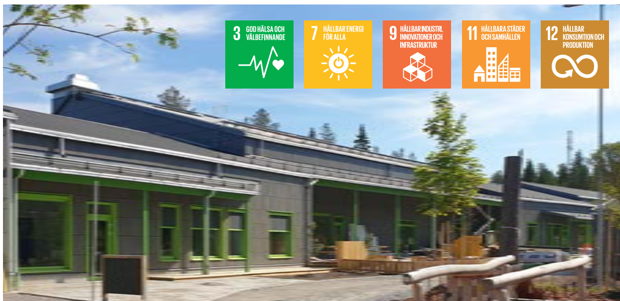
Strömnäsbackens förskola är en av de första anläggningarna med värmedriven kyla. FOTO: Marie Öqvist
