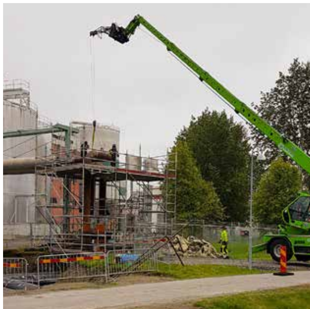
De gamla ledningarna har levererat värme i över 40 år, de nya säkerställer hållbar fjärrvärme en mycket lång tid framöver.
