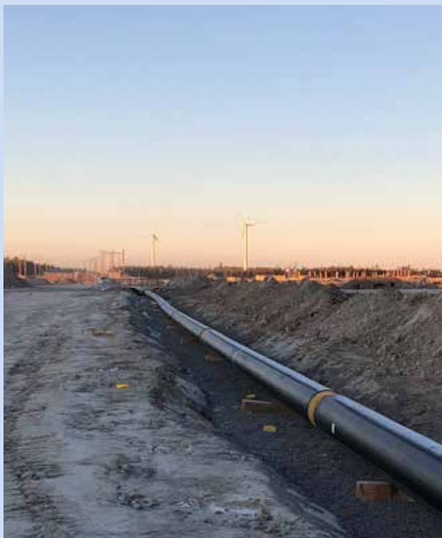
Den nya fjärrvärmeledningen är klar för att leverera hållbar fjärrvärme.
