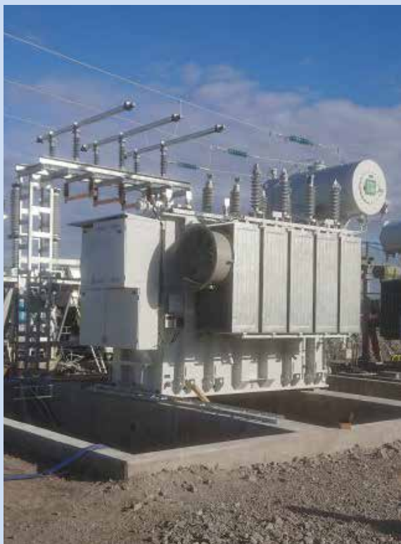
En av de två nya krafttransformatorer som är installerade på Haraholmens nya industriområde.
