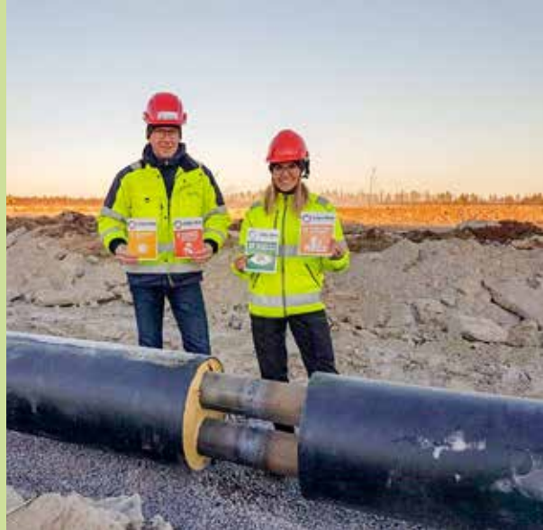
Rolf Öberg och Sofia Viksten vid den nya fjärrvärmeledningen.
