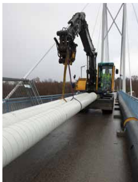
Den provisoriska ledningen ligger ovanpå bron och de gamla rören körs bort för att ge plats att montera de nya på sidan om bron.
