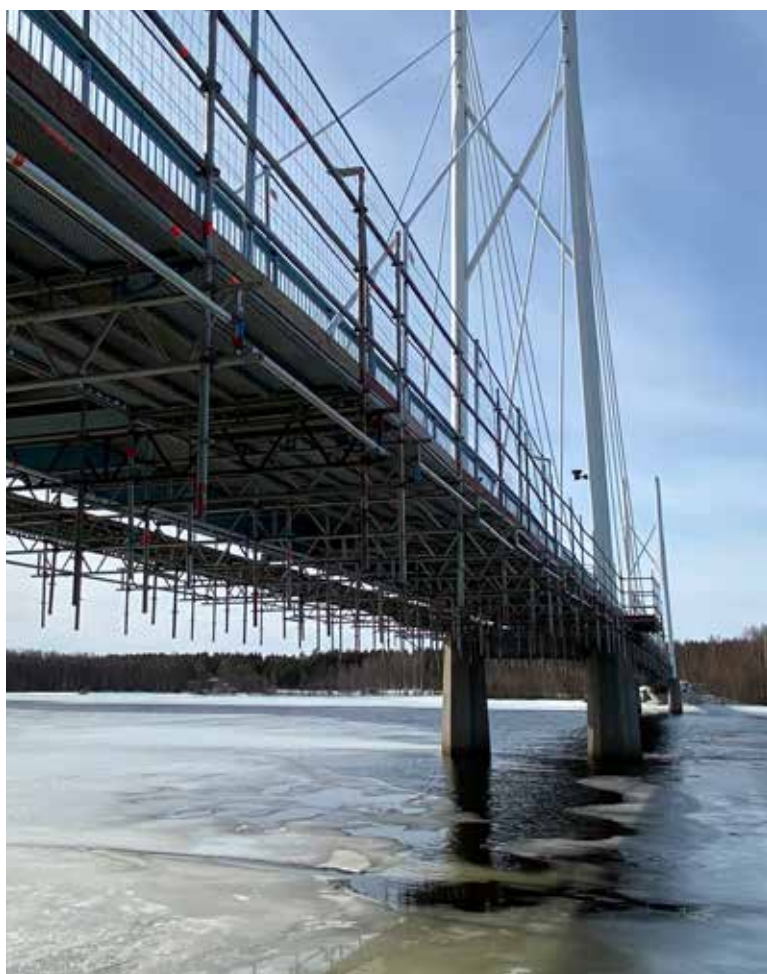
Den provisoriska ledningen ligger ovanpå bron och de gamla rören körs bort för att ge plats att montera de nya på sidan om bron.
