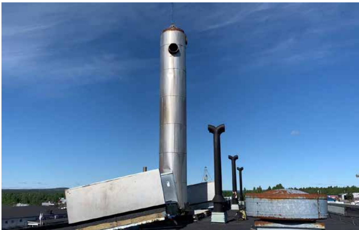
De gamla värmeväxlarna lyfts ut för att ge plats för de nya.
